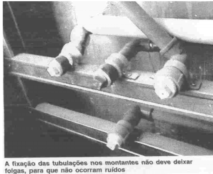
Figura 3.27 – Fixação das Tubulações FONTE: Revista MO, n 18075
