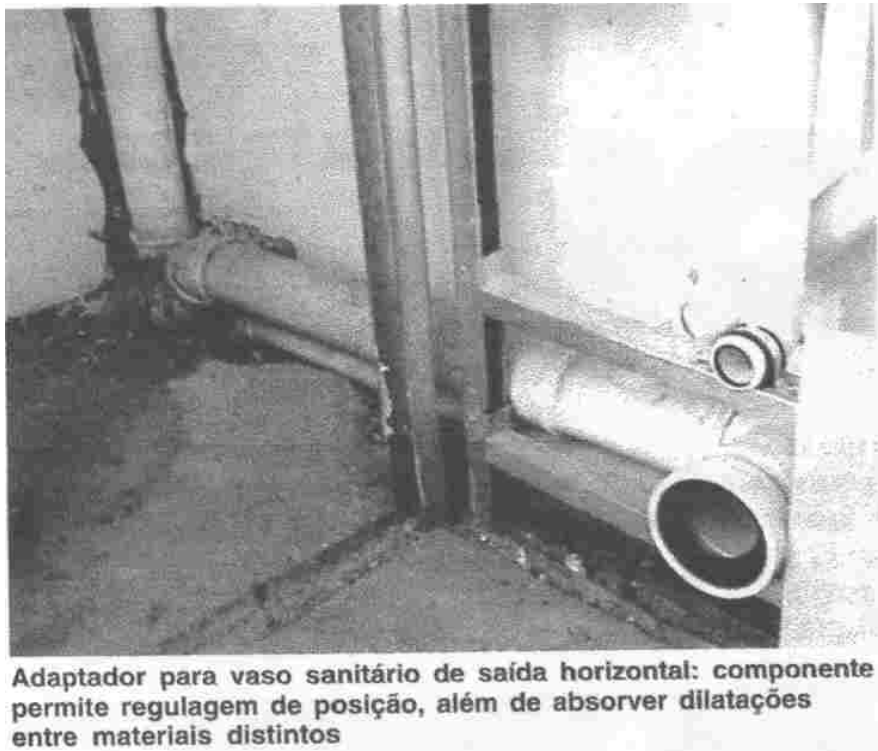
Figura 3.32 – Fixação das Tubulações. FONTE: Revista TÉCNICE, n 19 ano 1995
